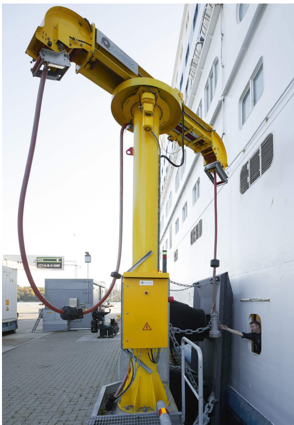
Fjernstyrt landstrømtilkobling. Foto: Cavotec
