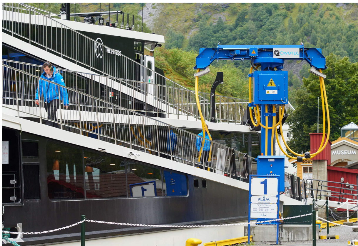
Fjernstyrt landstrømtilkobling. Foto: CAVOTEC.
