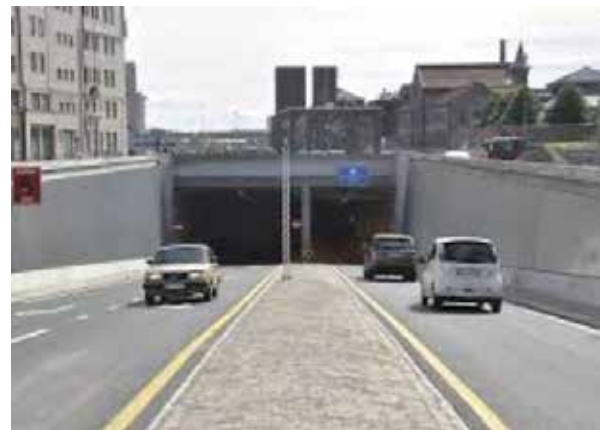
Operatunnelen er en moderne to løps tunnel under havnebassenget i Oslo med høy teknisk standard (Foto: Statens vegvesen).
