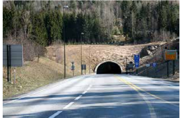
Vestre portal av Oslofjordtunnelen på Hurumsiden. (Foto: Trond Strandsberg).
