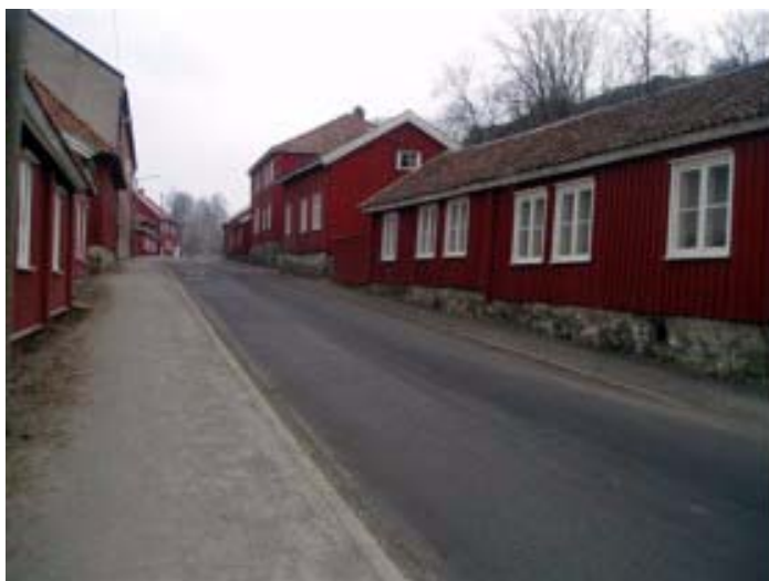
Figur 2-6 Tett trehusbebyggelse i Moss. Foto: Mossregionens brannvesen.
