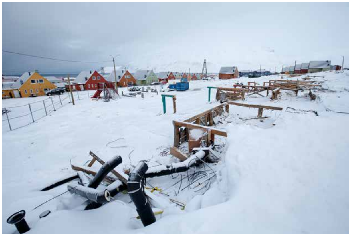
Berre fundamentet står igjen etter at dei øydelagde spisshusa i Longyearbyen er fjerna. Foto: NTB scanpix.
