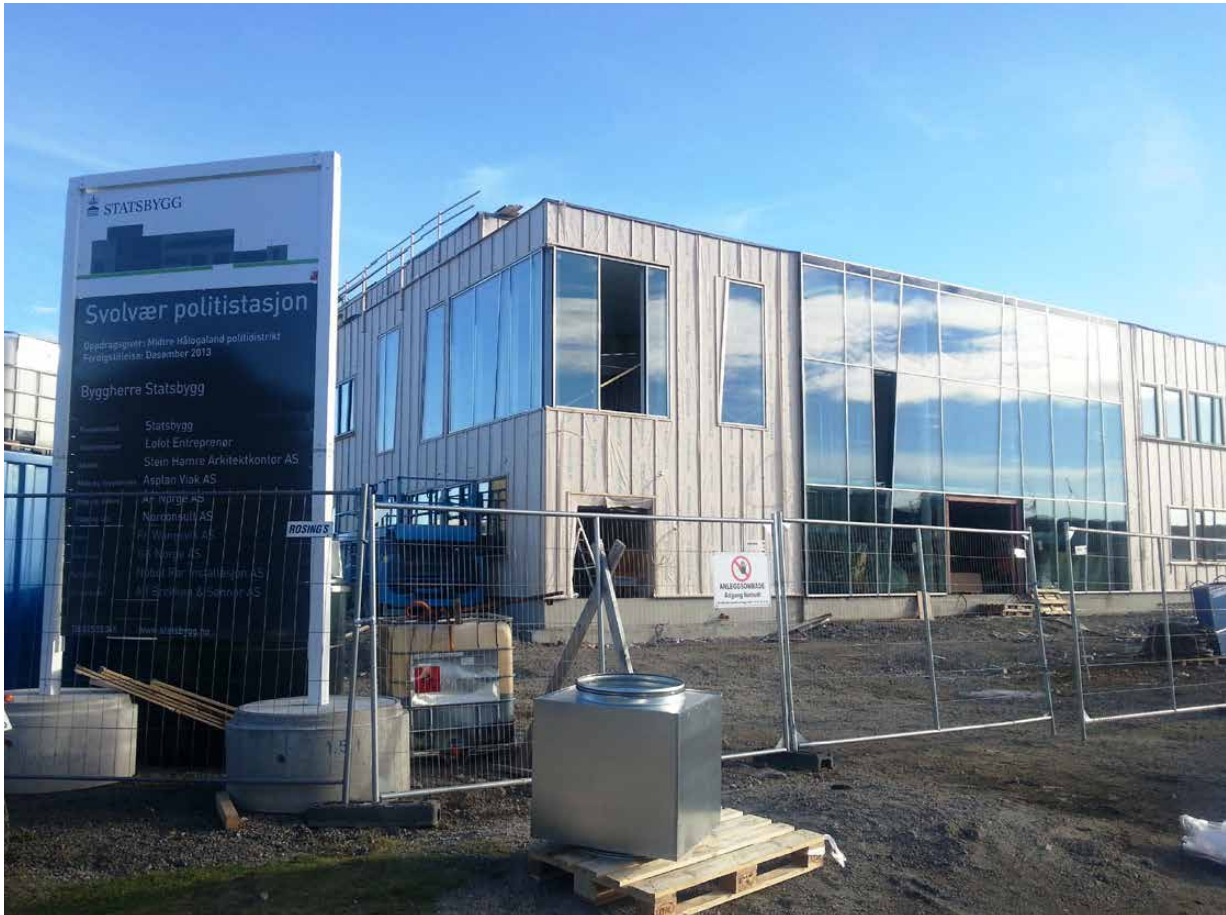
Bygging av Svolværs nye politistasjon der gulvets høyde er lagt på 4 meter over dagens havnivå (det omliggende området ligger på ca. 3 m.o.h.). Dette er i tråd med retningslinjene i den nye byplanen for Svolvær. Foto: DSB.
