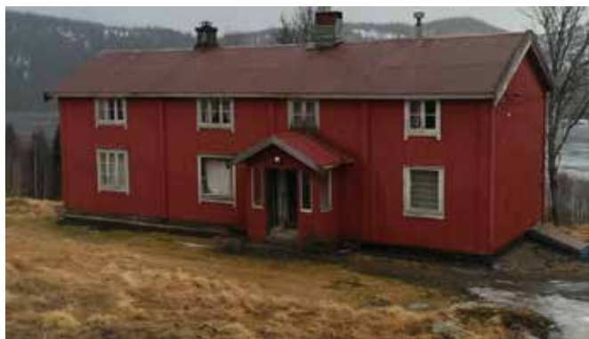
Fasade mot nord. Ingen vindu knust (nå).
