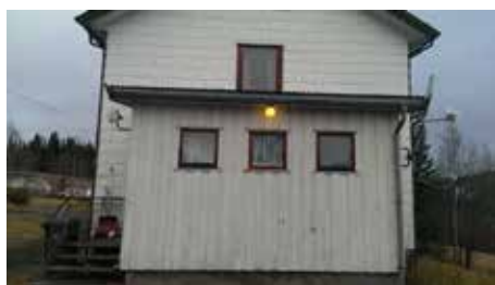
Vestvegg. Alle vinduer hele.
