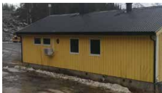
Langside nord. Ingen skader. ES opp til venstre.
