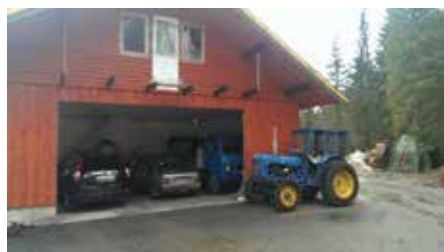
Fasade mot øst. Dør 2. etg vippet frem.
