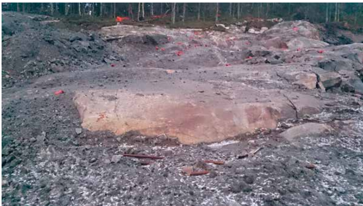
Foto 2: Bilde visende fjellparti rett bak der eksplosjonen skjedde. Bilde tatt av DSB den 18. desember 2013.
