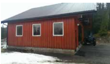
Fasade mot sør (bakside)
