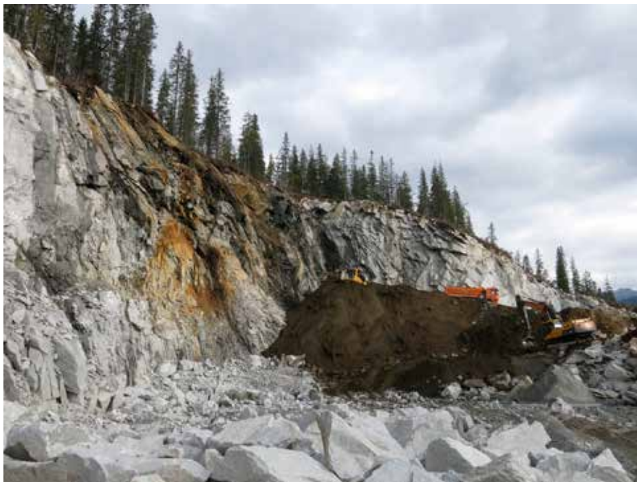
Foto 6: Sett fra eksplosjonssted mot fjellvegg i nordøst. Mørke fjellet er svakhetssonen som korse masseuttaket. Bilde tatt den 25. september 2014.
