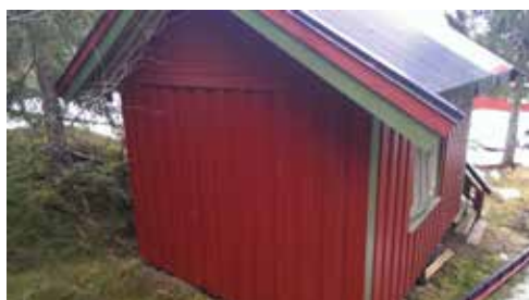
Vegg mot nord.
