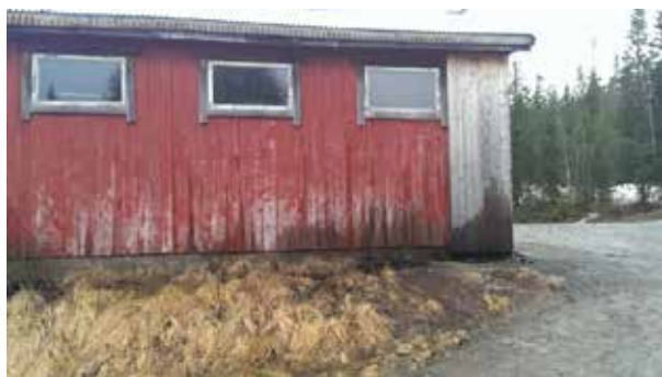
Sidevegg mot øst med vindu. Ingen knust.
