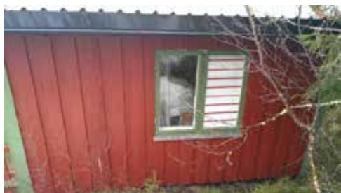
Bakside. Begge vindu hele.
