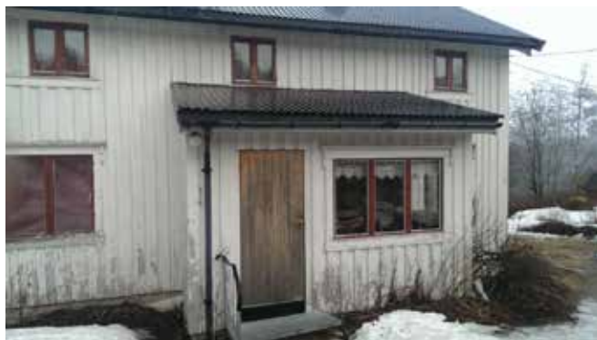
Fasade mot nord. Ingen skader.
