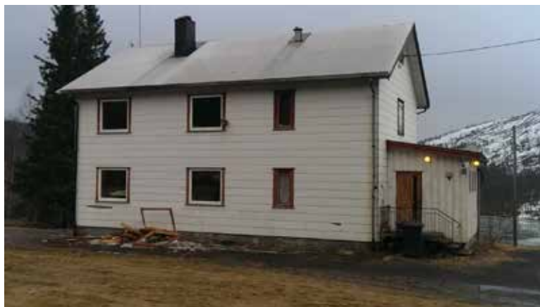
Nordside. De fire store vindu knust, de to små hele.
