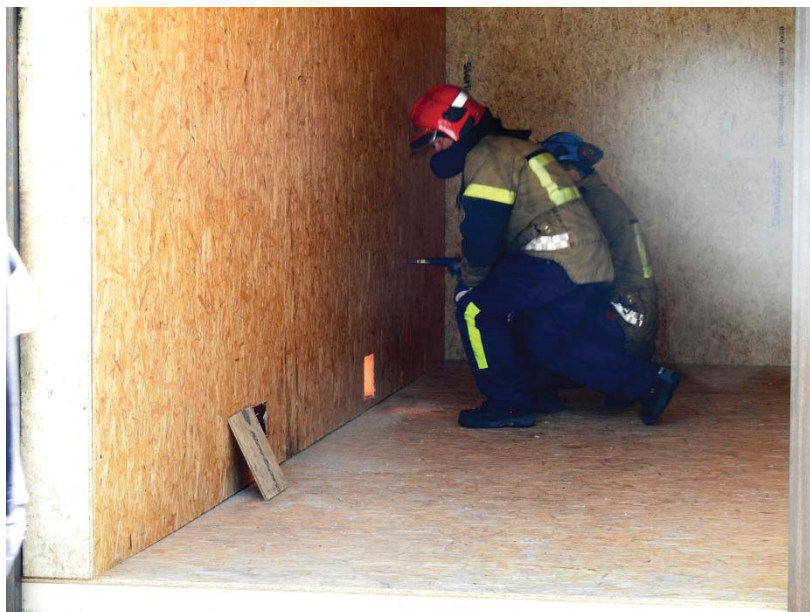
Figur 5-23 Antennelse av brann i hulrom i scenario B. To små branner blir antent, en i hvert av hullene på veggen. Tennkildene ble antent med en propanbrenner, og en plate ble spikret over hullet, slik at brannen kun fikk spre seg inne i veggen. Tennkildene ble antent med ca. 5 sekunders mellomrom.
