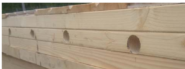
Figur 5-16 Massivvegg boret i bunnen.
