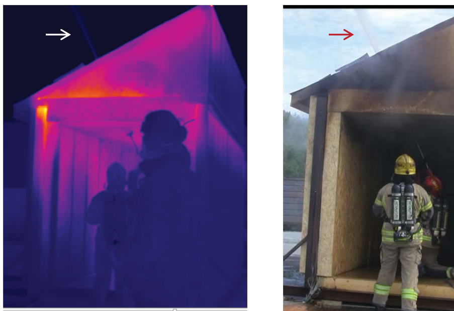
Figur B-14 Test 3B – Slokking gjennom flere hulrom går fint. Bildene viser slokking fra korridor og opp i loftet. Legg merke til at på dette tidspunktet har strålen vært så lenge på samme punkt at den har skjært seg gjennom de tre OSB-platene, slik at mesteparten av vannet forsvinner ut i lufta.
