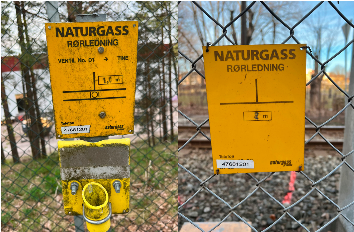
T.v. eksempel på merking av avstengningsventil. T.h. eksempel på skilting av gassrør (Foto: DSB).
