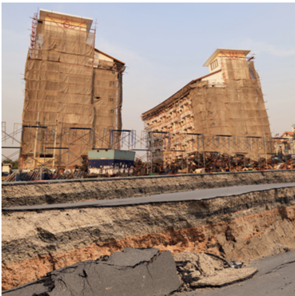
Ødelagt vei og skadede bygninger etter jordskjelv (Foto: Colourbox.com)
