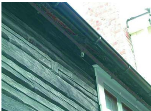
Fasadepresprinkleranlegg kan forhindre at bygningen blir antent fra utsiden. Foto: Anne Steen-Hansen, Tommy Skålvoll.
