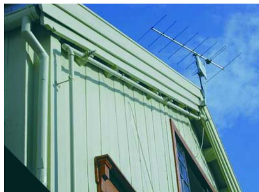
Fasadepresprinkleranlegg kan forhindre at bygningen blir antent fra utsiden. Foto: Anne Steen-Hansen, Tommy Skålvoll.
