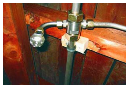
Vanntåkeanlegg på loftet kan hindre at en brann sprer seg ut av bygningen. Foto: Bjørn Egil Rossebø.
