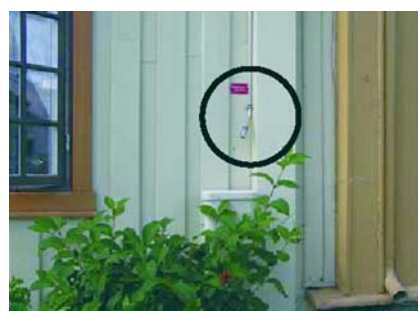
Brannvesenet kopler på vann til vanntåkeanleggene fra utsiden av bygningen. På bildet til høyre ser vi også hvordan vannrørene er ført inn på loftet. Foto: Anne Steen-Hansen.
