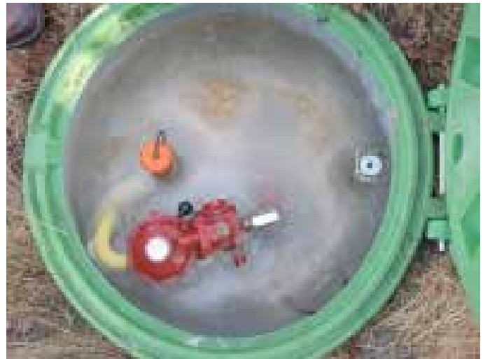
Figur 2. Tankdom full av is. (Foto: Oslo kommune, Brann- og redningsetaten)
