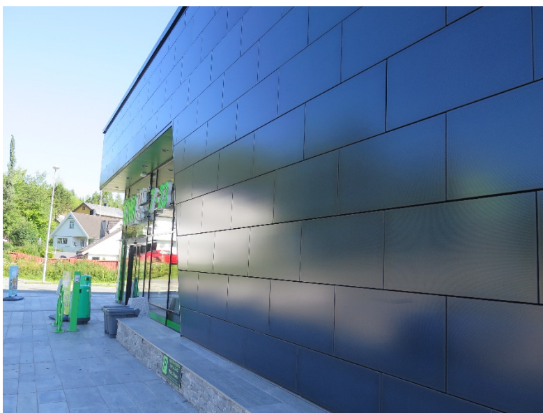
Figur A-1 Fasaden på Kiwi Dalgård i Trondheim er kledd med solcellemoduler. Foto: RISE Fire Research.
