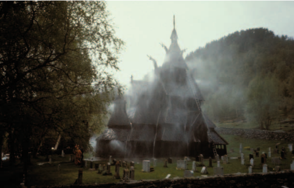
Utvendig sprinkler i funksjon
