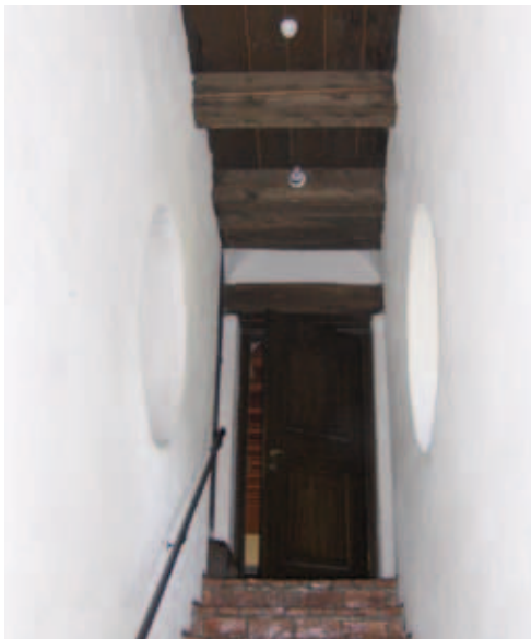
Alternativ merking av rømningsvei. Spotlight er brukt i stedet for markeringsskilt
